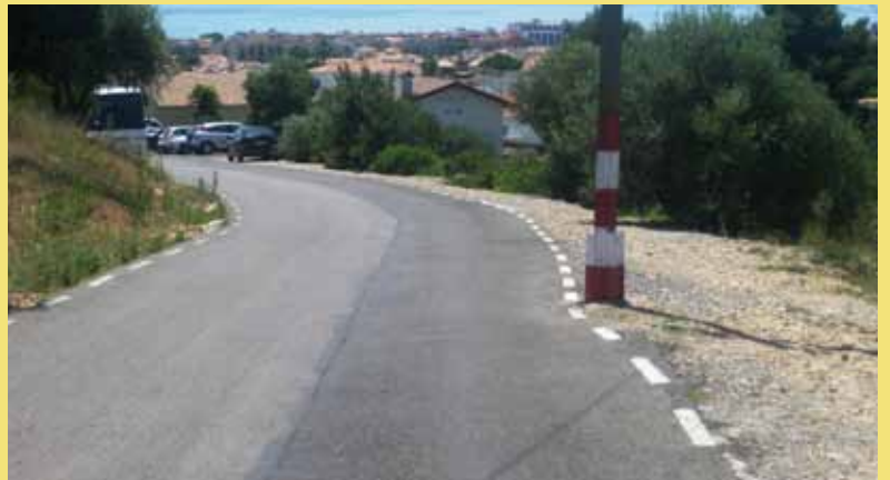
Imatge del punt afectat, amb el pal elèctric abans de la intervenció.
