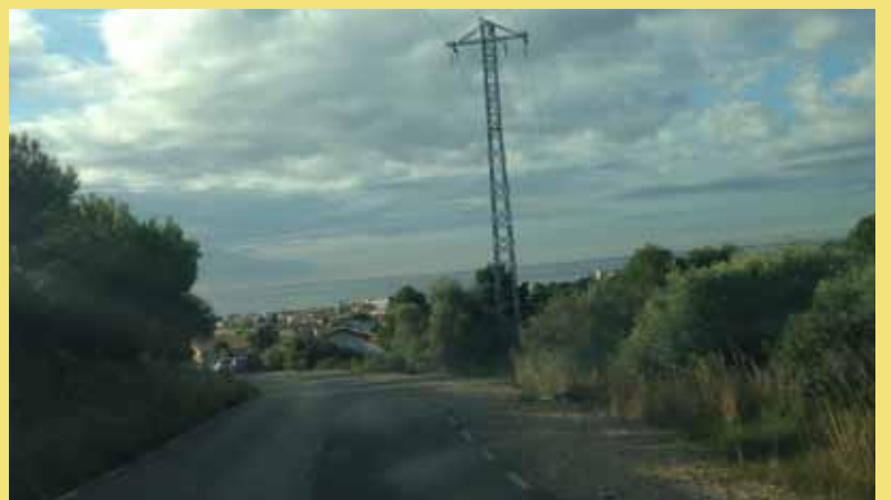
Imatge del mateix punt, amb el pal elèctric ja traslladat.
